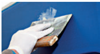
Fill using blade
