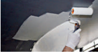
Apply antifouling over primer
